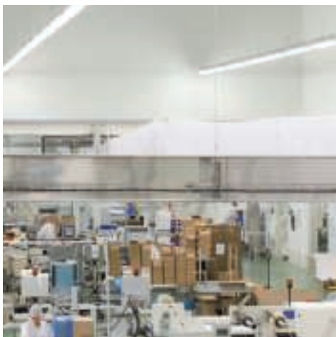
▲ Pour éclairer la salle de production principale, les canalisations électriques préfabriquées assurent l'alimentation des luminaires. ►
