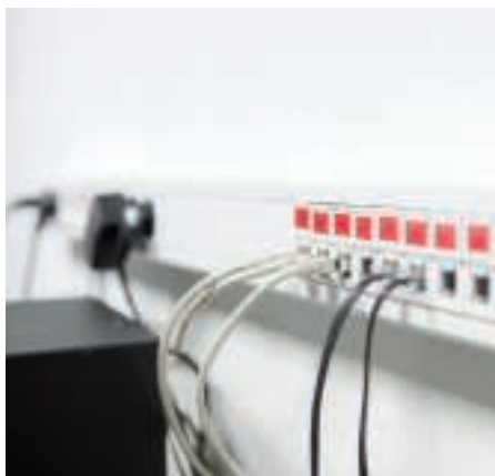
▲ Courants forts et faibles, les goulottes à clippage direct peuvent accueillir un grand nombre de prises.
