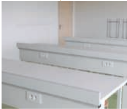
◀ Des prises du programme Mosaic judicieusement placées permettent d'alimenter chaque poste de travail.
