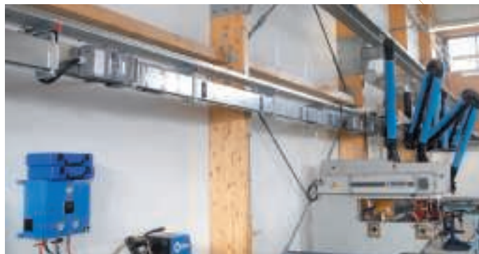
▲ Les canalisations électriques préfabriquées sont une solution idéale pour alimenter des machines susceptibles d'être déplacées.
