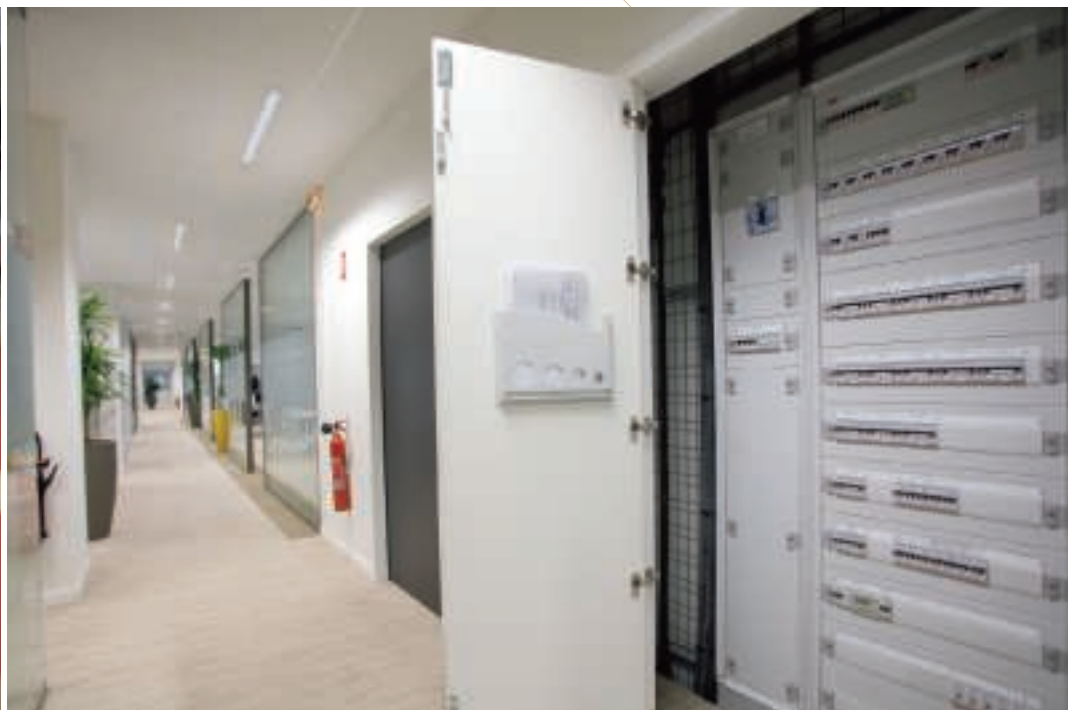
▲ Les appareils modulaires Lexic avec leur nombre de modules réduits permettent de gagner de la place dans les armoires divisionnaires.
