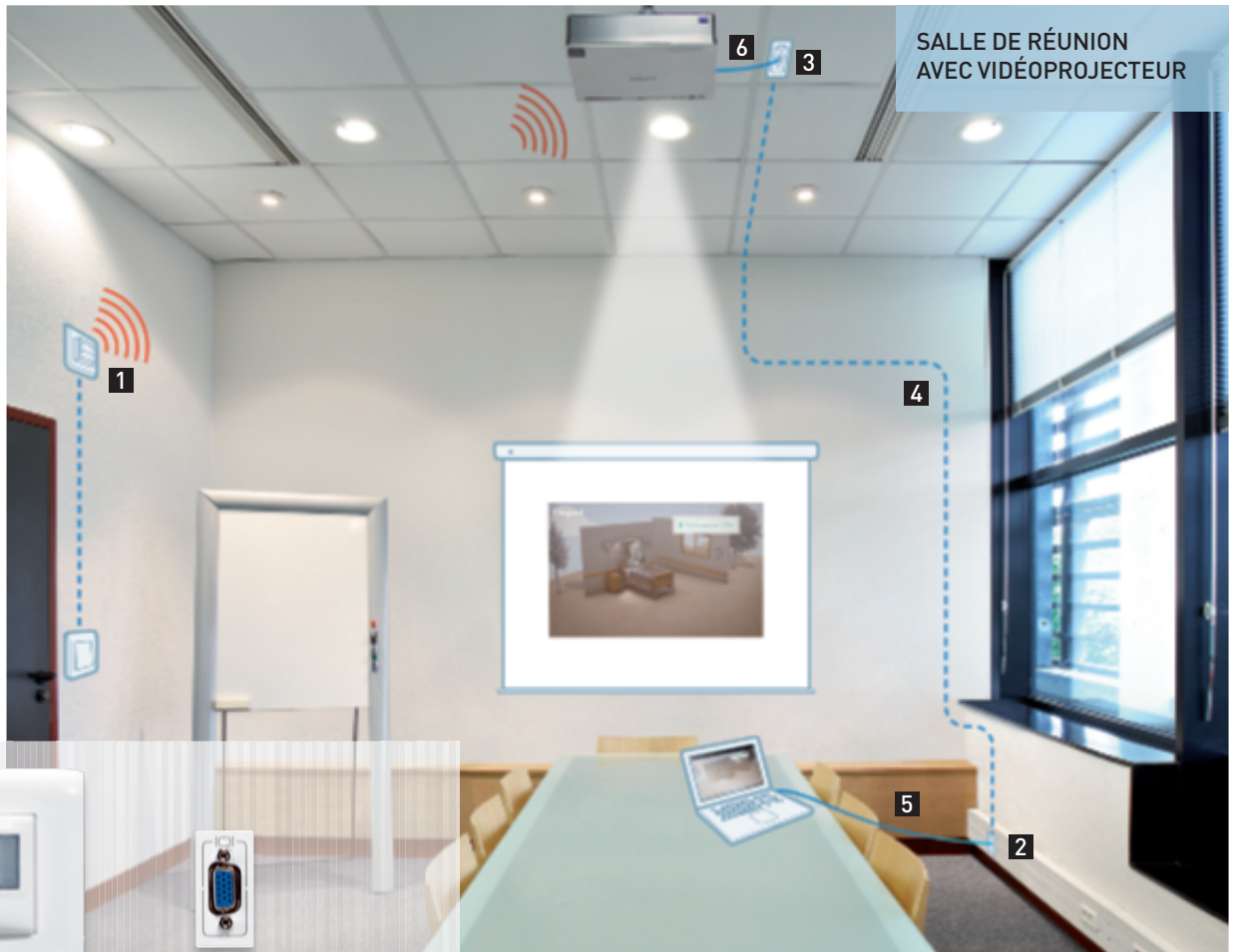
1 Commande ON/Veille infrarouge réf. 0 787 99 pour vidéoprojecteur, associée à un bouton poussoir
