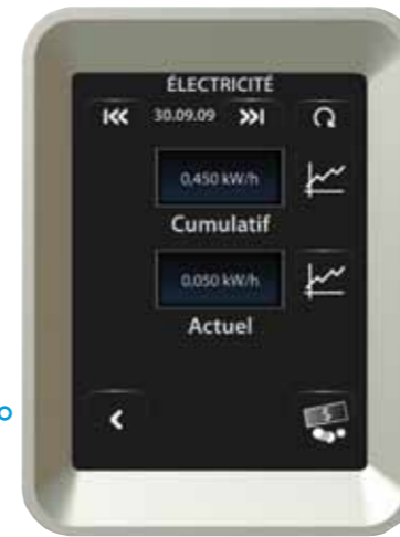
Fenêtre de consommation du circuit "électricité" (instantanée/cumulée)
