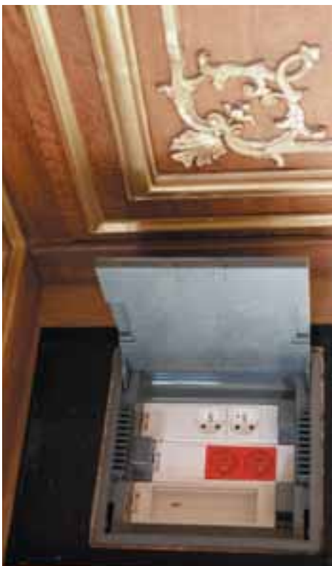
▼ Quel que soit le lieu, les boîtes de sol constituent toujours le moyen le plus discret pour la mise à disposition des courants.
