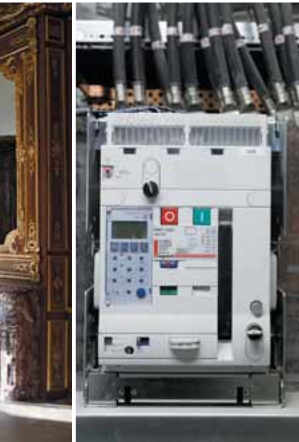
▲ Maîtrise de la consommation de l'énergie facilitée grâce aux nouveaux disjoncteurs DMX 3 équipés d'une unité de protection électronique.
