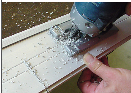
Les flancs se découpent facilement à la scie sauteuse
