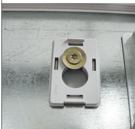
Les lumières en trou de serrure permettent l'accrochage et le décrochage des coffrets
