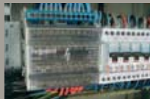
Bornier complémentaire pour conducteur neutre sur répartiteur réf. 048 86
