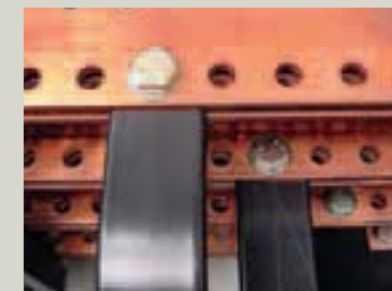
Serrage direct de barres souples de 5 mm d'épaisseur entre deux barres rigides à même espacement
