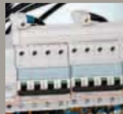
Peigne tripolaire Lexic réf. 049 42 pour répartition triphasée
