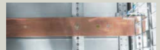
Borne principale constituée d'une barre cuivre en bas d'armoire
