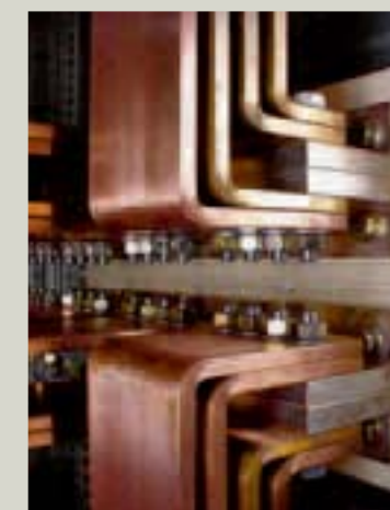
Raccordement de 4 barres de 100 x 10 sur chaque prise arrière d'un DMX 4000 débrochable
