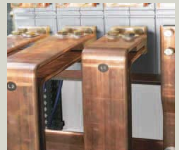
Raccordement sur plage d'un DMX débrochable
