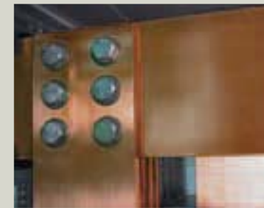
Raccordement sur barres 120 x 10 (4000 A)
