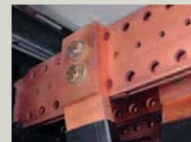
Serrage d'une barre 50 x 10 avec contreplaque
