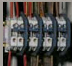
Dérivation sur blocs Viking par peigne de liaison equipotentielle sécable réf. 394 21
