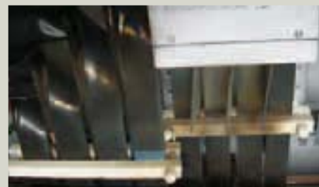
Bridage de barres souples
