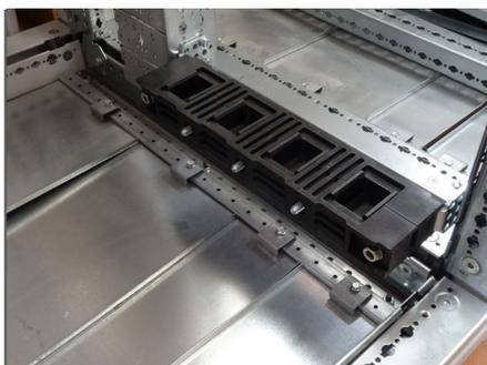
Fixer les supports entre le montant fonctionnel et le montant de structure
