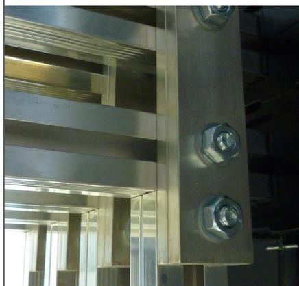
Raccordement d'un jeu de barres aluminium sur un jeu de barres principal double réalisé en barres aluminium
