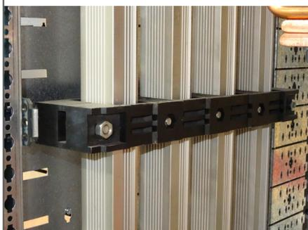
Positionner les barres et serrer les supports afin d'assurer le maintien des barres.
