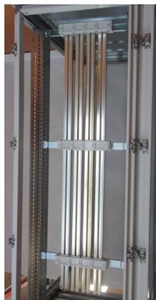
Vérifier le bon serrage des barres en revissant les vis des supports.
