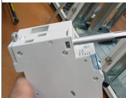
Pour les disjoncteurs 1P + N **bornes à vis** il faut préalablement ouvrir les bornes de l'appareil avec un tournevis PZ2.
