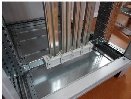
Fixer le support talon réf. 4 044 60 entre les montants fonctionnels et positionner les barres
