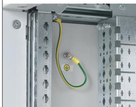
Réalisation de la liaison équipotentielle d'un flanc.
