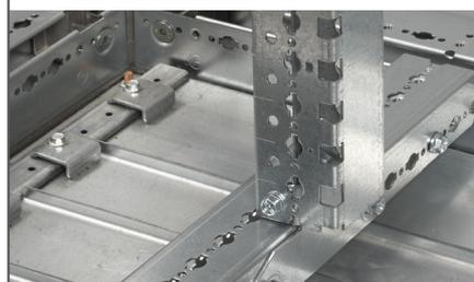
Fixer le montant fonctionnel le plus étroit sur les traverses rapportées. L'autre montant se fixe directement sur la structure de l'armoire.
