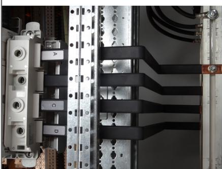
Raccorder ensuite le module d'alimentation au jeu de barres par l'intermédiaire du kit de raccordement préfabriqué.
