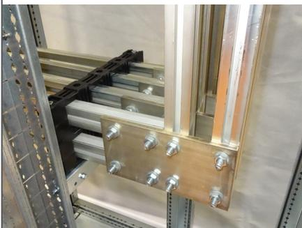
Les supports réf. 0 373 66 et 0 373 68 peuvent être doublés pour réaliser un jeu de barres d'intensité 3200 A max. Si le jeu de barres dérivé est également double, la connexion sera réalisée avec les grandes plaques réf. 0 373 83.
