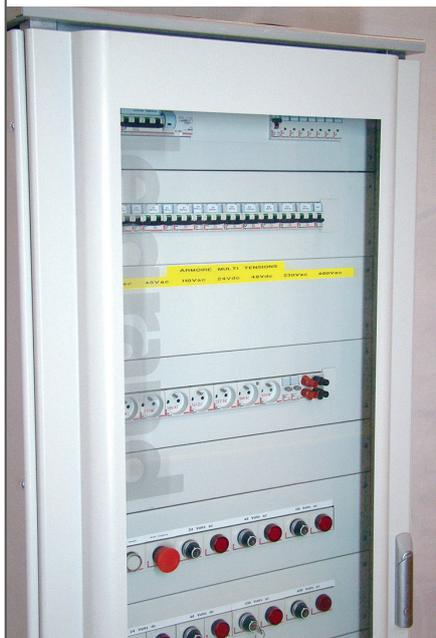
L'indice de protection IP 55 est obtenu par le montage d'une porte (sauf en cas de montage sur caniveau).
