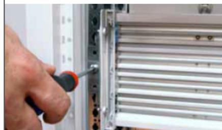
Positionner et fixer le répartiteur de rangée sur les montants fonctionnels de l'armoire.
