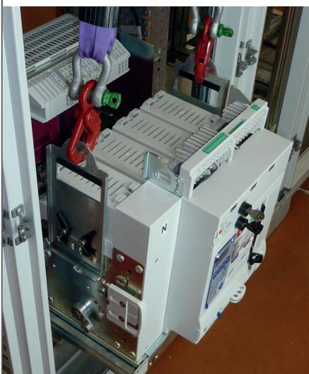
Mise en place d'un DMX<sup>2</sup> débrochable dans sa base
