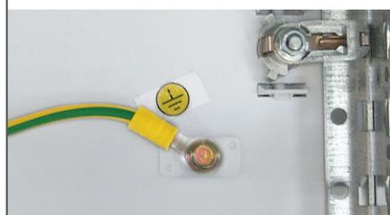
De l'autre côté le cordon se fixe sur le goujon de la porte ou d'un plastron
