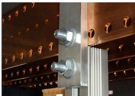
Raccordement d'un jeu de barres aluminium sur un jeu de barres principal réalisé en barres plates avec les plaques de connexion simples réf. 0 373 82
