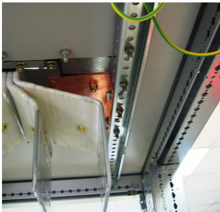
Le dispositif de liaison se fixe sur les traverses de renfort à travers le toit
