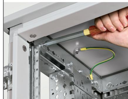
Dans les armoires sans gaine à câbles interne, les deux montants support plastrons se fixent directement sur la structure de l'enveloppe.
